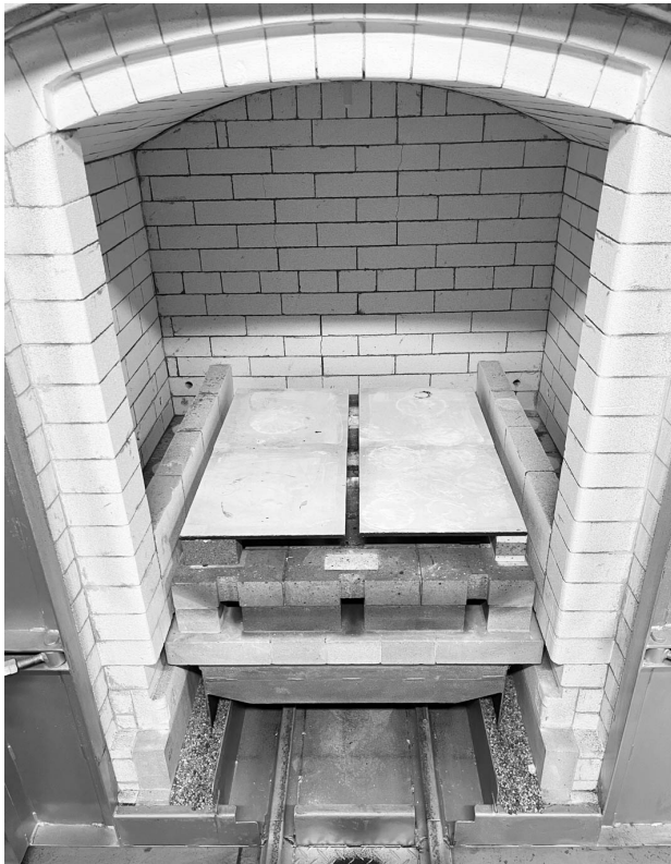
図4-3 ガス窯の内部
