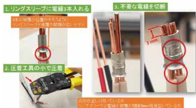
図 60 リングスリーブを用いた電線の圧着
