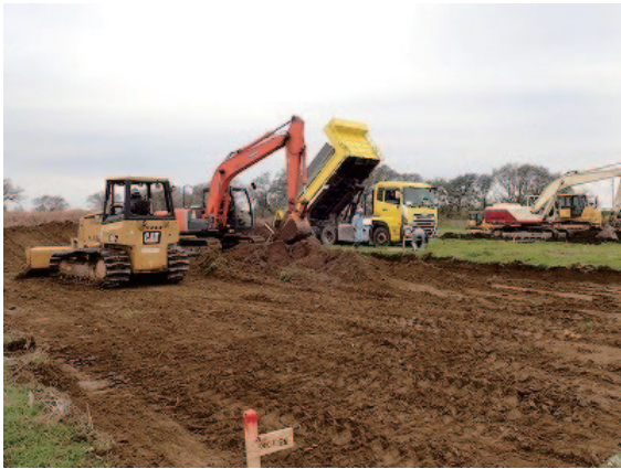
写真5 まき出し、転圧の状況
