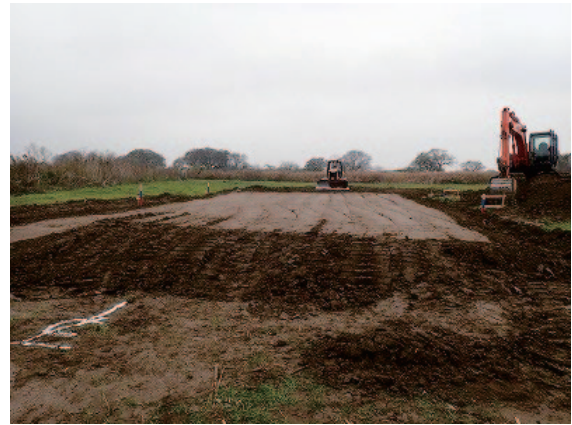
写真6 2層目転圧後の状況
