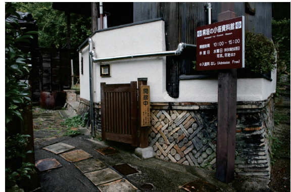
図2 陶磁器を外装材、舗装材等の景観材料として使用した例（瀬戸市洞地区において2014年8月28日に筆者撮影）
