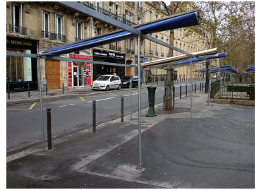
写真18 道路固定式システム店舗の屋根
