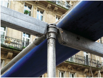
写真16 道路固定式システム店舗の詳細
