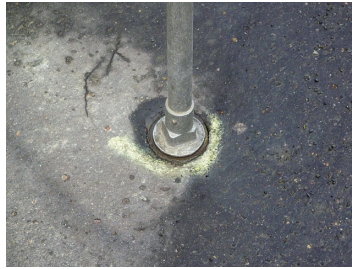
写真17 道路固定式システム店舗の詳細
